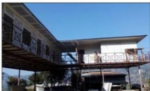
Le deuxième chantier se situe à Kaphaldanda, au nord de Katmandou, dans un village difficilement accessible. Il est nécessaire de reconstruire complètement un bâtiment scolaire.
