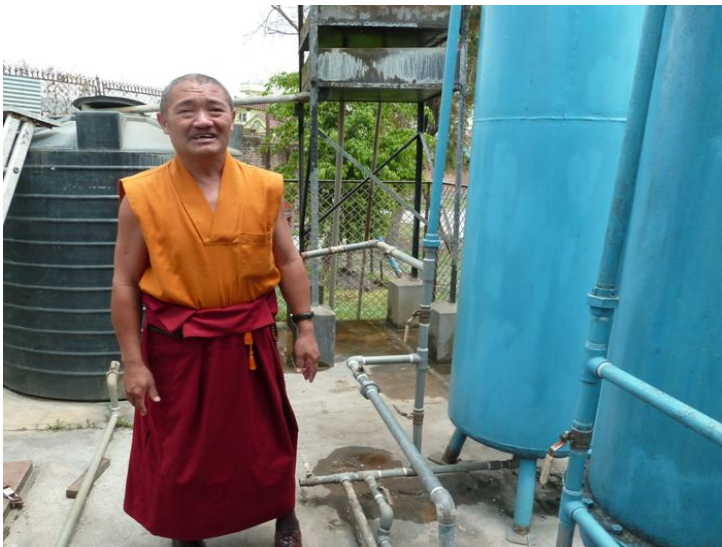
Travaux de remise en état du réseau d'eau potable financés par notre association Ecoliers du Monde
