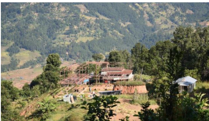
Mise en place de la structure métallique
