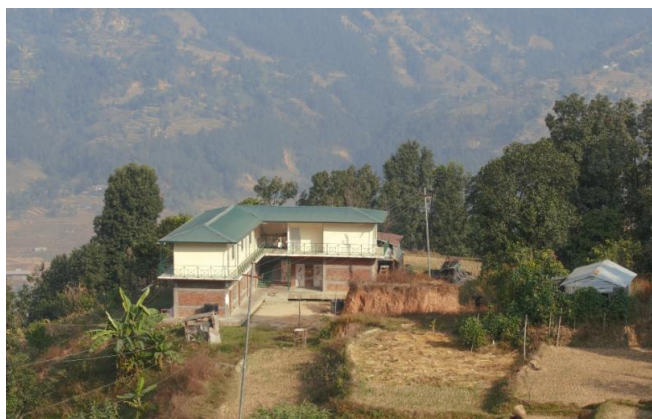
Mise en peinture des murs fin 2018
